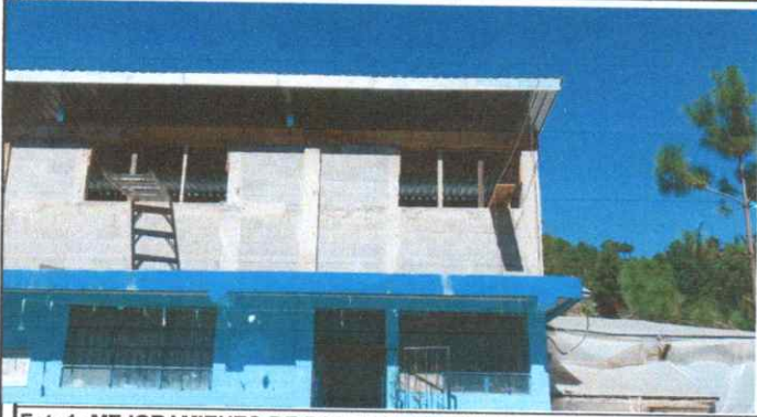
Foto1: MEJORAMIENTO DE PAREDES EN AULAS
