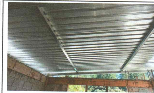
Foto1: CUBIERTA DE METAL.
